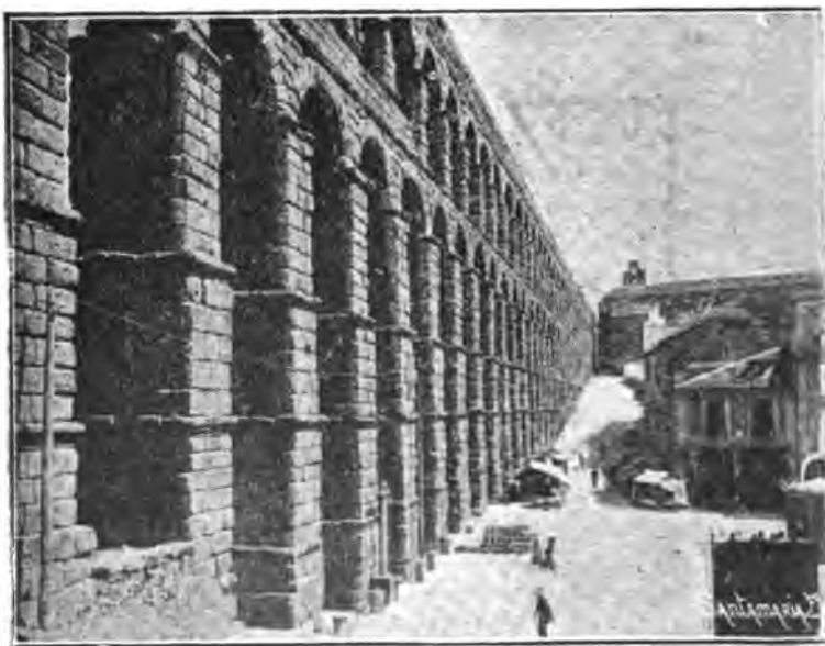
Fig. 156.—Acueducto de Segovia: siglo II.
