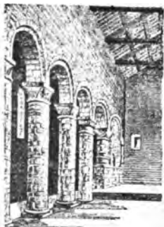
Fig. 172.—Interior de la iglesia de Polenta (Italia).
