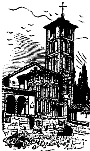
Fig. 206.—Iglesia y torre de Sta. M. a de Cuéllar
